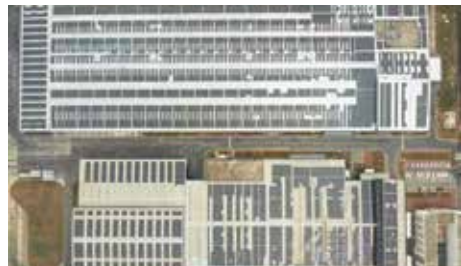
今麦郎（河源）分布式光伏发电项目 地点：广东省河源市 规模：11.39MWp
