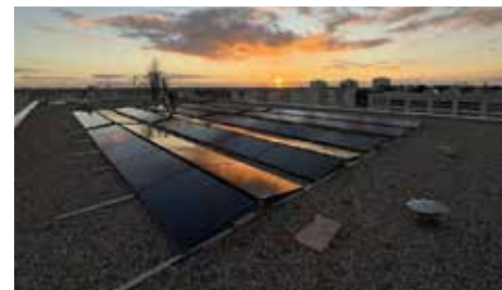
Poitiers 政府税务局大楼50 kWc 屋顶光伏项目 地点：法国Poitiers 规模：约50 kWc
