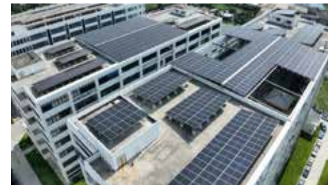
东莞万江中创汇智盈科技园光储充一体化BIPV项目 地点：广东省东莞市 规模：2.824MWp分布式光伏+1.1MW/2.2MWh储能
