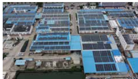
福东正佑照明电器有限公司 地点：江苏省连云港市东海县 规模：3MW
